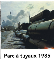
Parc à tuyaux 1985
